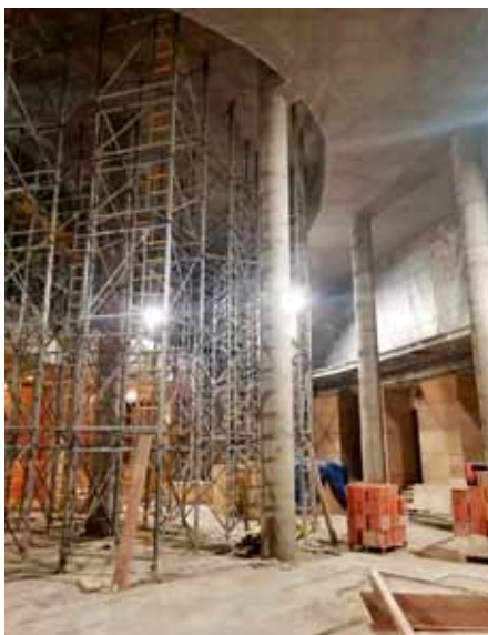
Monolit stropu nad 1. PP
