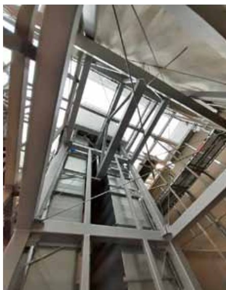
Šachta OTK uvnitř pod střechou
