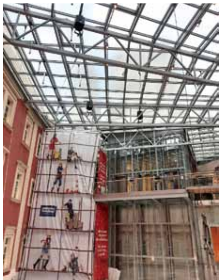
Montáž šachty OTK v atriu probíhala za provozu v oddělené části centra
